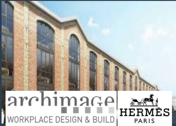
Aménagement immeuble de bureaux HERMES (93) - MOE Fluides
