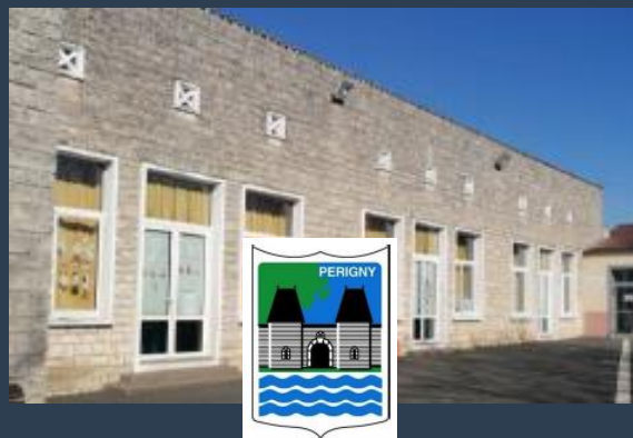
Audits énergétiques de 3 groupes scolaires et une cuisine centrale (17)
