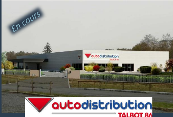
Construction d'un bâtiment industriel (86) MOE TCE / OPC
