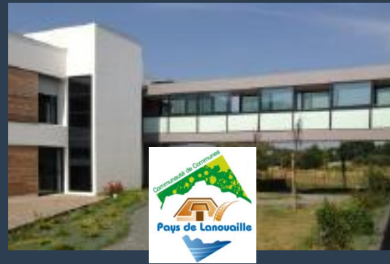
Construction de la résidence EHPAD « Les jardins de Plaisance » (24) - MOE Fluides + CSSI
