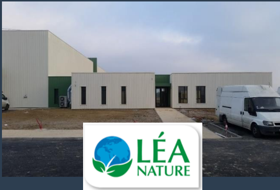
Construction d'une usine agroalimentaire (47) – MOE Fluides
