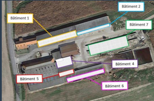
Construction d'une centrale PV de 475 KWc sur 5 bâtiments existants – CENON (86)
