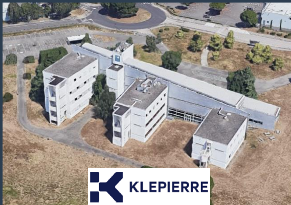
Rénovation de l'immeuble de bureaux ABA (31) - MOE TCE
