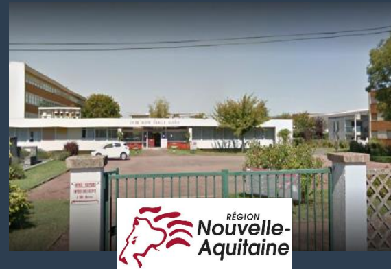
Divers travaux de rénovation Lycée CAMILLE GUERIN (86) - MOE TCE
