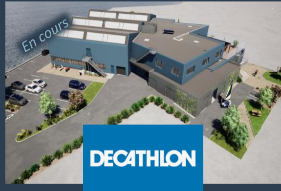
Construction du centre de recherche TRIBORD (17) - MOE Fluides
