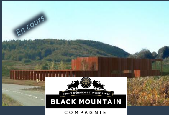
Construction d'une distillerie et chai de stockage (34) – MOE TCE / AMO process
