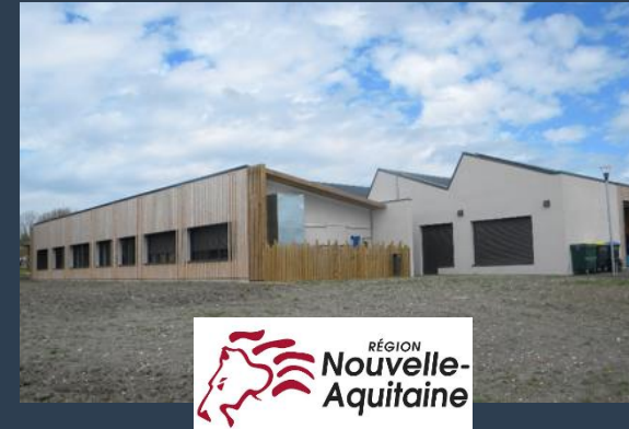
Construction du pôle paysage Lycée MATHIRON – MOE Fluides / ENV / CSSI
