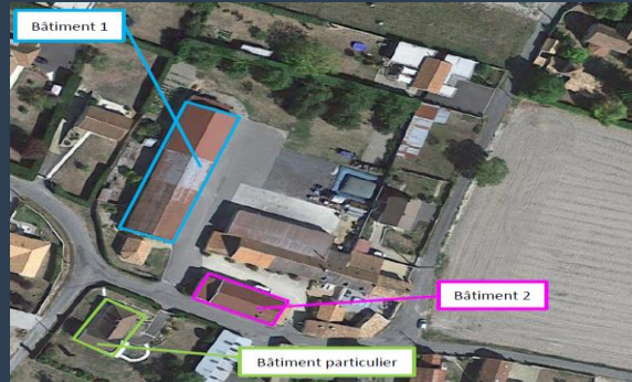
Construction d'une centrale PV de 100 KWc sur 2 bâtiments existants – AVAILLE EN CHATELLERAULT (86)
