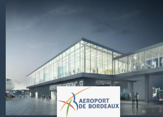
Concours conception réalisation – Construction du satellite 3 (33) – MOE Fluides
