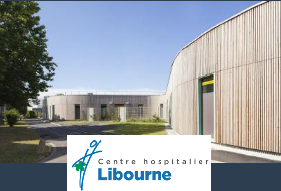
Construction d'un service de soins intensifs psychiatrie (33) - MOE Fluides
