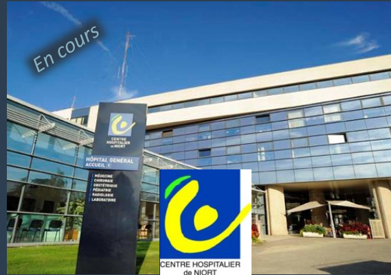
Rénovation du V120 (79) - MOE Fluides
