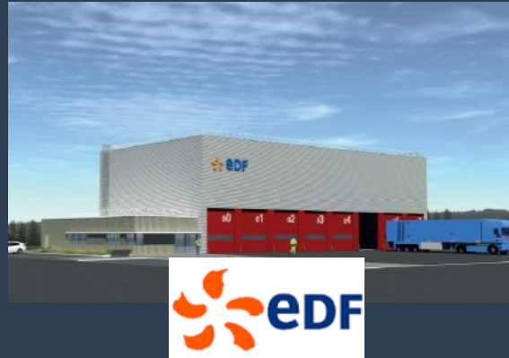
Construction d'un hangar FARN 2 – CNPE CIVAUX – MOE TCE / OPC
