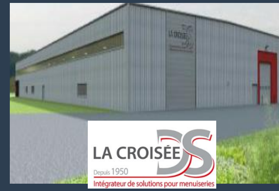
Construction d'un bâtiment industriel (86) MOE TCE / OPC
