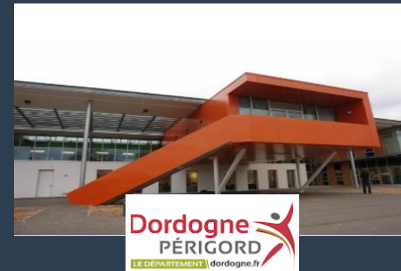
Construction du collège HQE ARTHUR RIMBAUD (24) – MOE Fluides / CSSI
