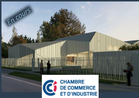
Construction d'un pôle de formation (17) – MOE Fluides
