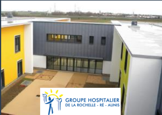
Réhabilitation et extension du CSPA du « Fief de la Mare » (17) - MOE Fluides
