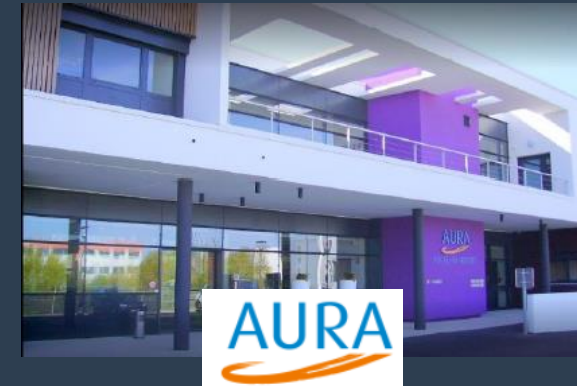
Construction d'un centre de dialyse AURA (86) - OPC
