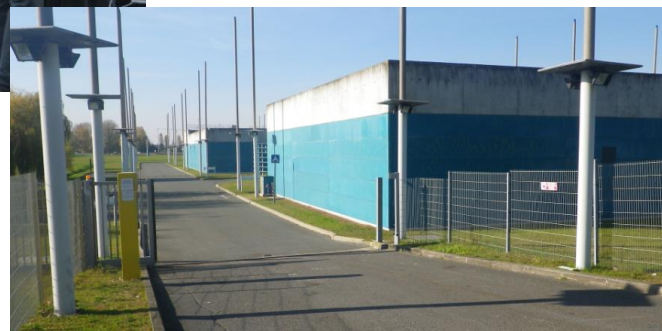
» Visite de station de traitement des eaux usées
