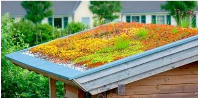
@ ATELIER DU VÉGÉTAL – Melting Pot Système de toiture végétalisée issu de l'économie circulaire
