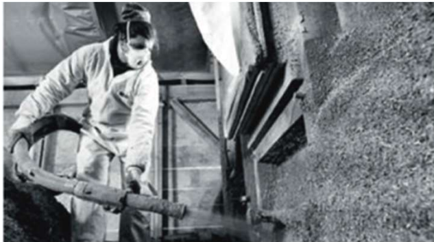
@ SAINT-ASTIER Béton de chanvre projeté
