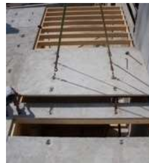
@ WURTH Plancher bois béton
